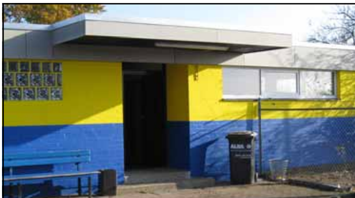
Das Sportheim mit neuem Anstrich und neu gedecktem Dach
